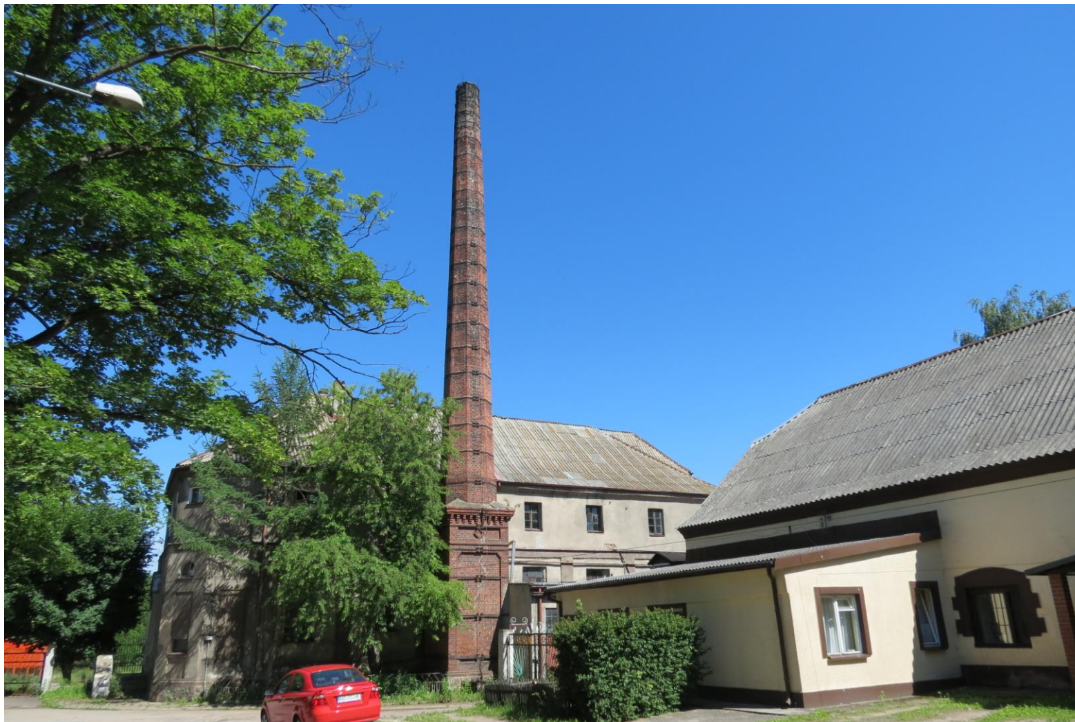
Widok ściany frontowej i szczytowej z NW na SE
