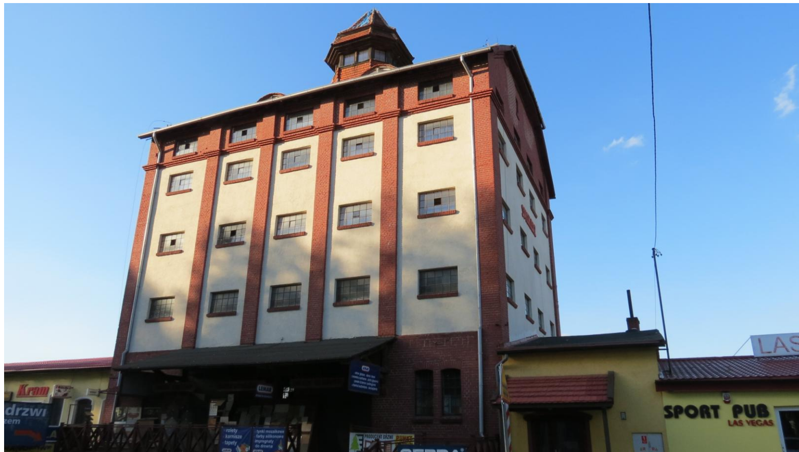
Widok ściany frontowej i szczytowej z SE na NW
