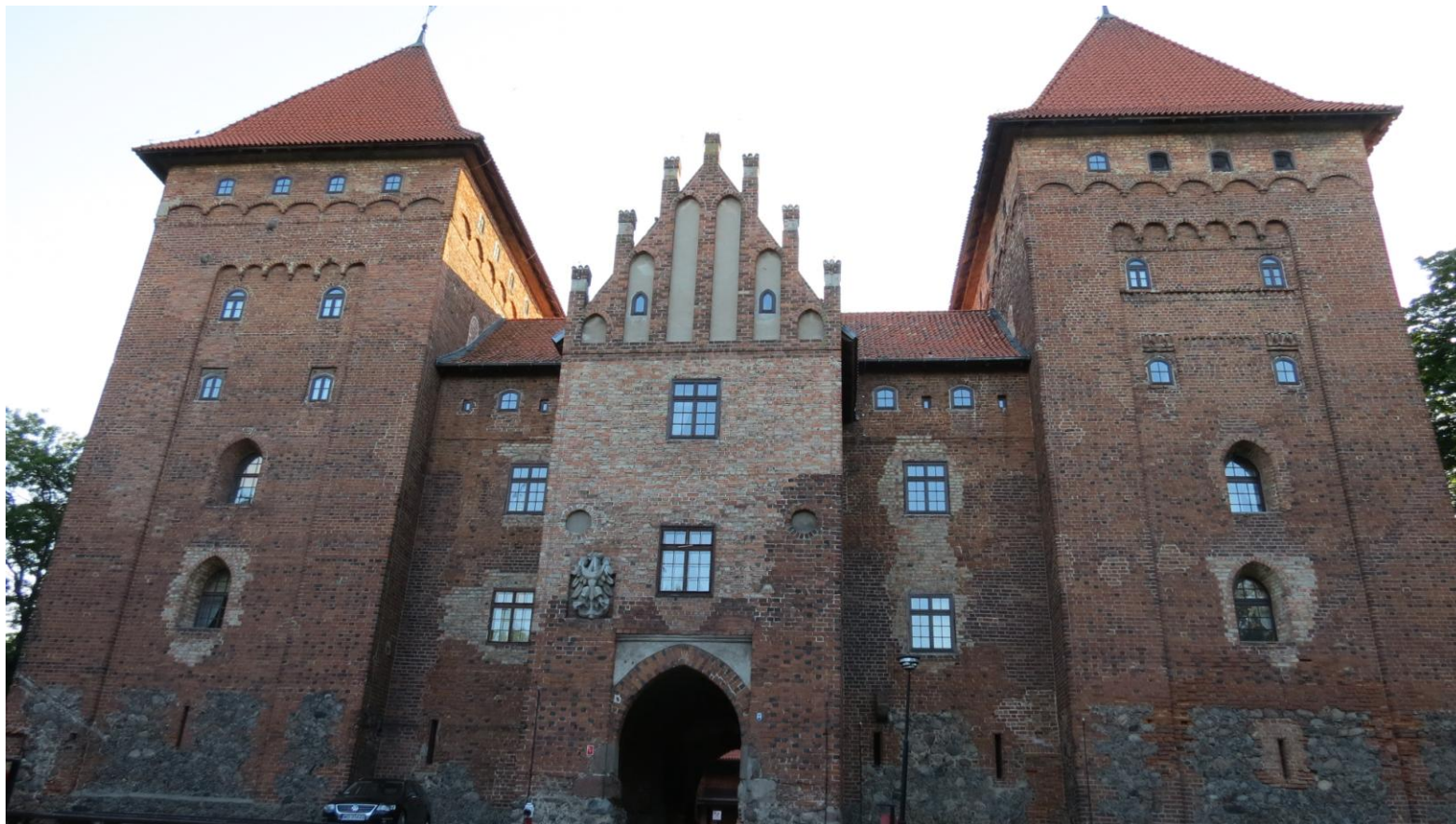
Widok skrzydła zamkowego z SE na NW
