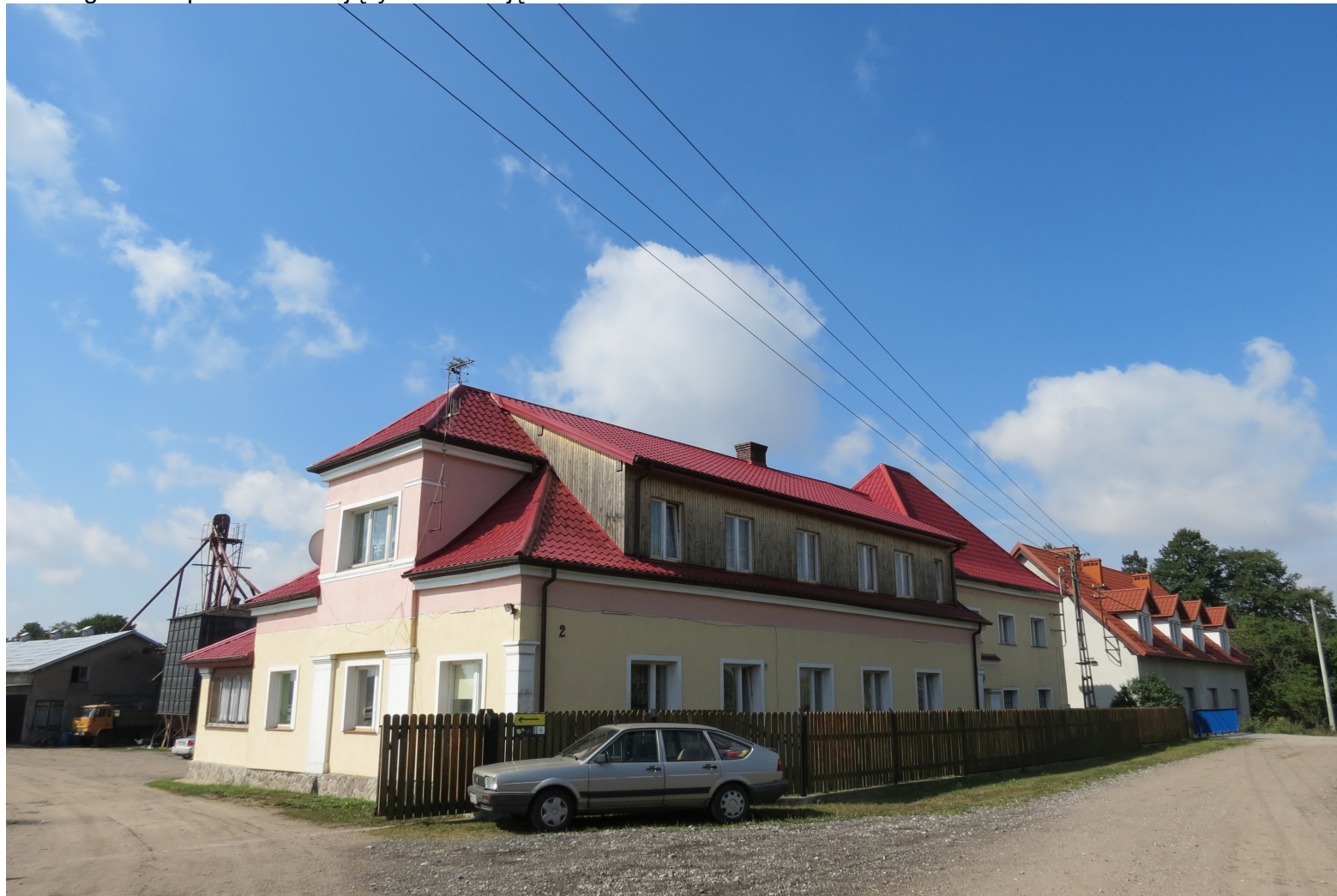
Widok budynków zespołu z NE na SW
