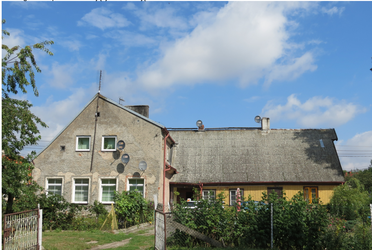
Widok ściany frontowej i szczytowej z S na N
