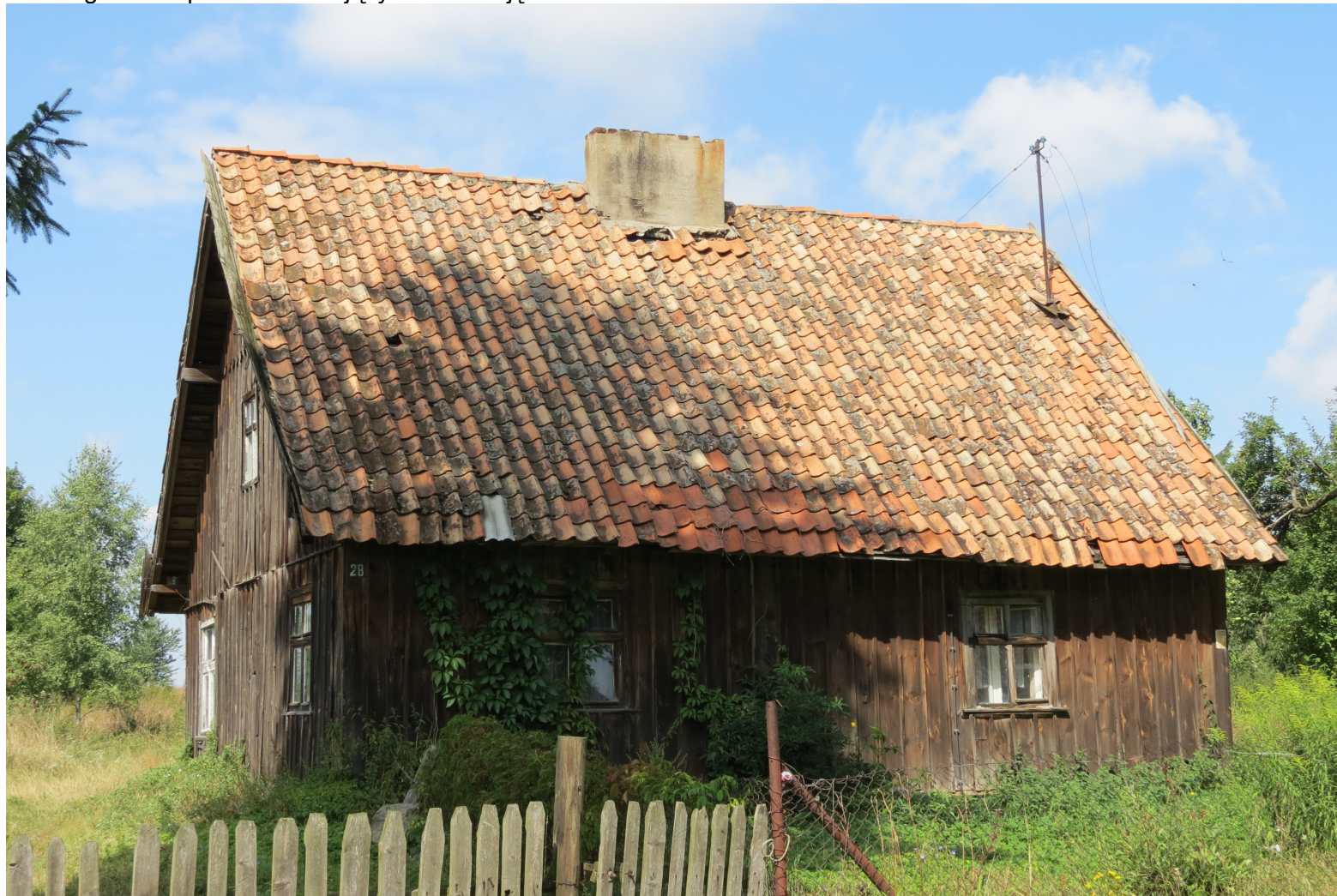
Widok ściany frontowej i szczytowej z E na W
