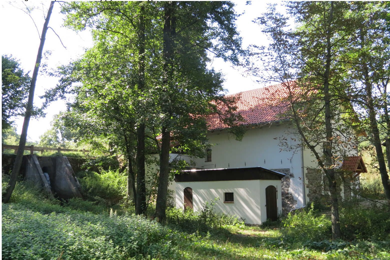
Widok budynku młyna z NE na SW
