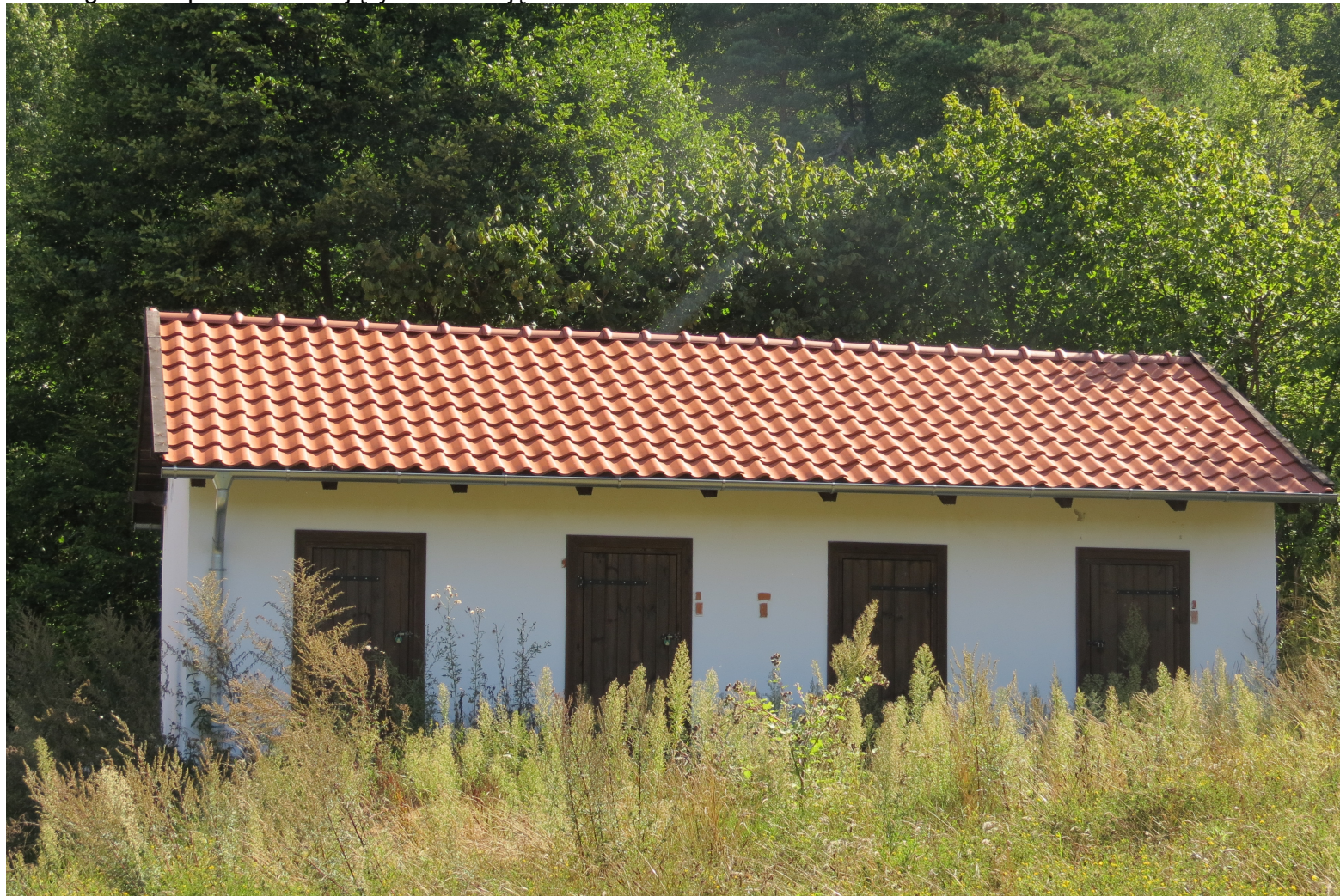
Widok ściany wzdłużnej z NE na SW
