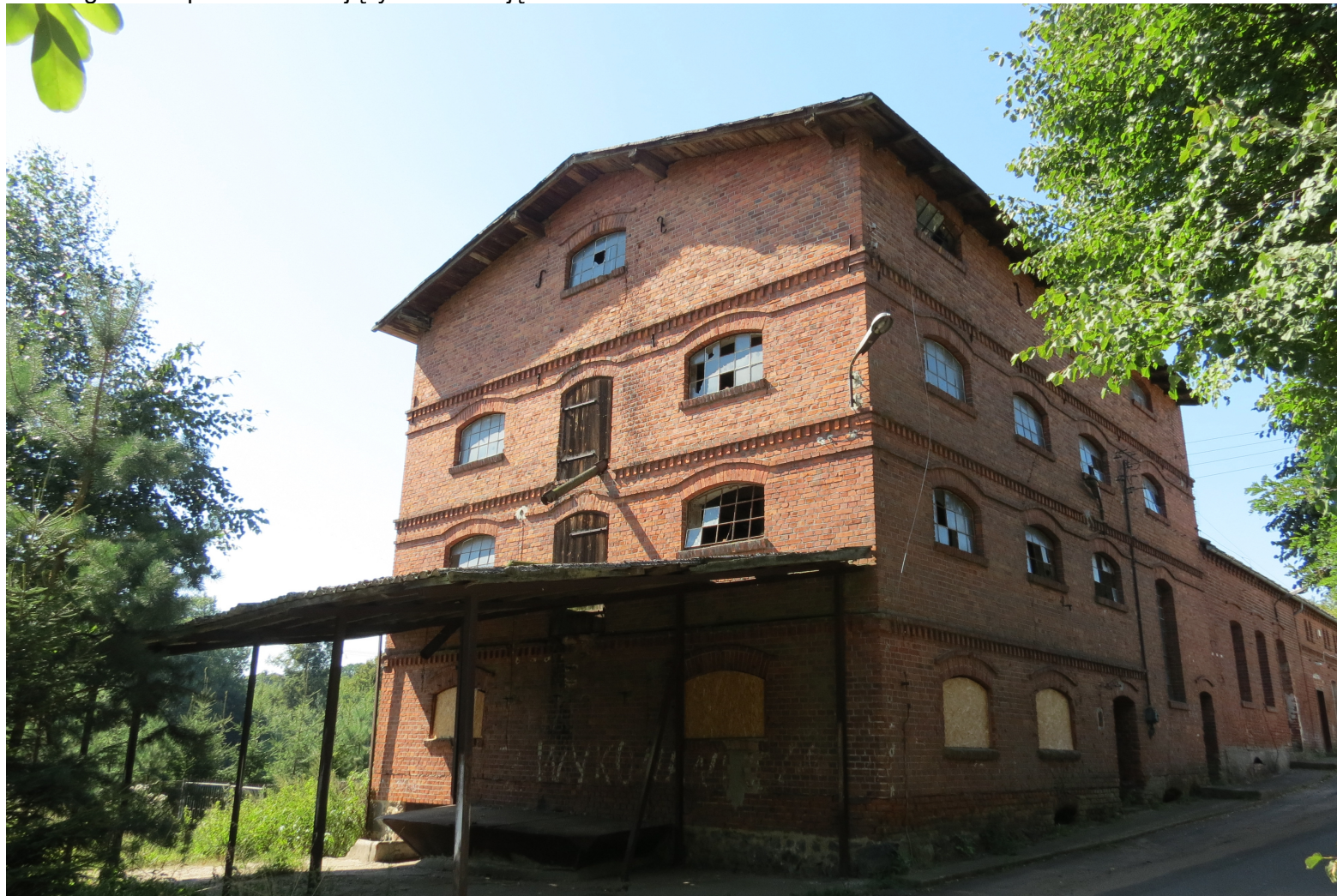
Widok ściany frontowej i szczytowej z NE na SW
