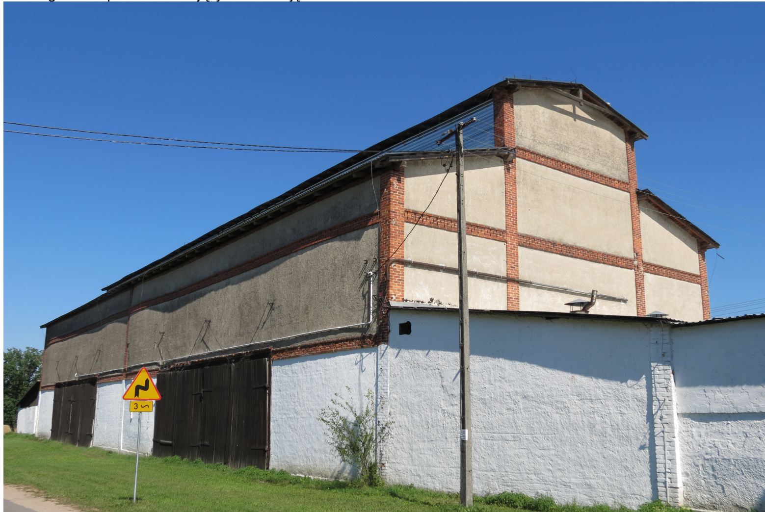
Widok ściany wzdłużnej i szczytowej z S na N
