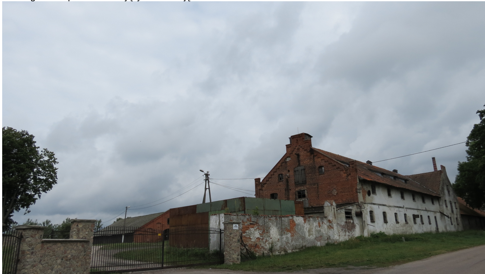
Widok ogólny folwarku z SW na NE
