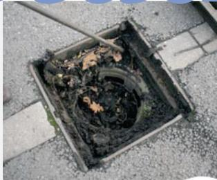
Grobfilter entfernen und reinigen.
