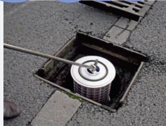
Filterpatrone aus dem Einsatz entnehmen.
