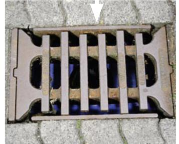
INNOLET®-Filterpatrone in den Einsatz einbringen, auf Zentrierung achten und dann den Grobfilter einsetzen. Beim Rechteck-Aufsatz empfehlen wir eine Adapterplatte anzupassen, um das gesamte Oberflächenwasser durch das INNOLET®-System zu leiten. (Bei quadratischen Gullies ist normalerweise keine Adapterplatte notwendig.)
