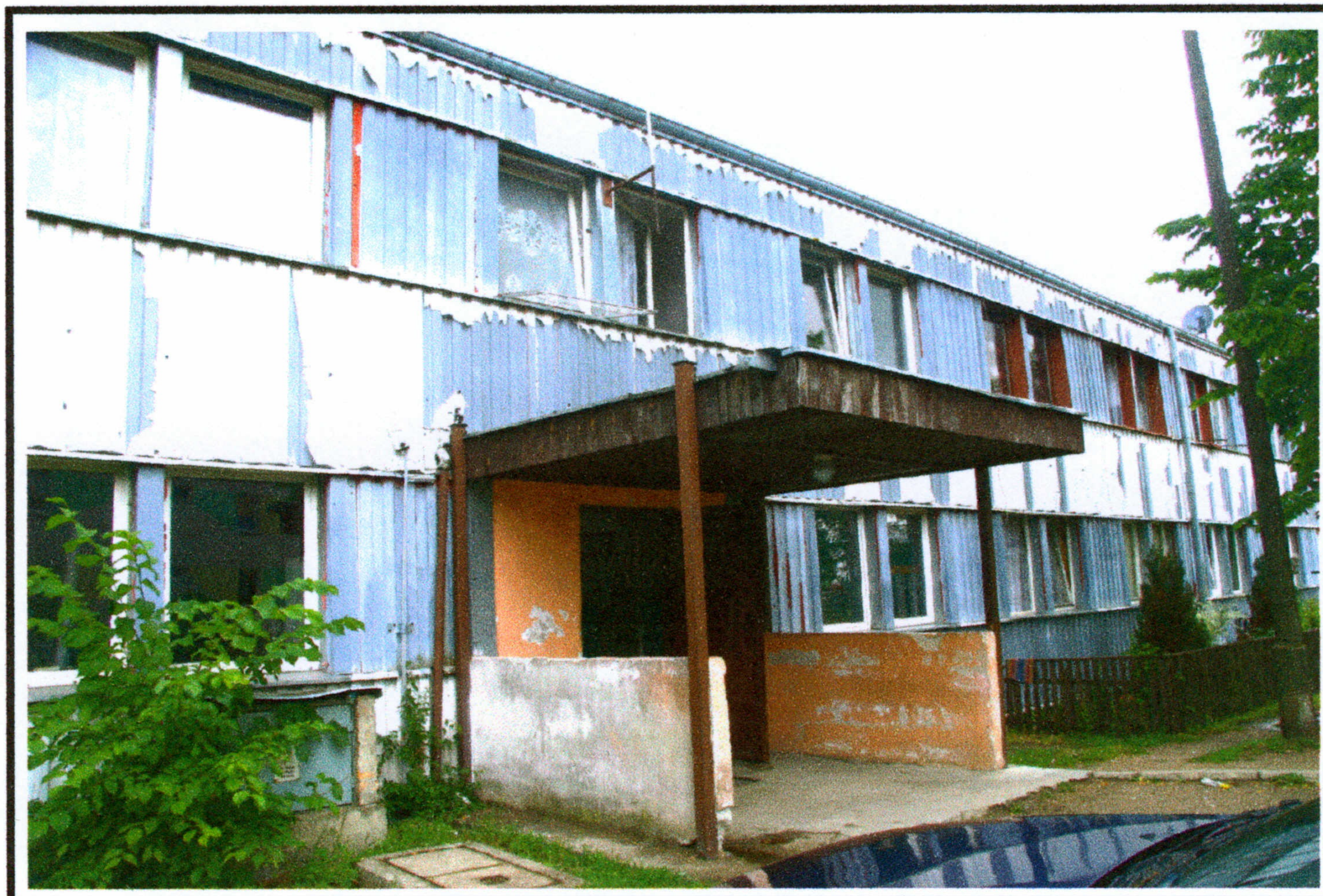
Elewacja wschodnia - wejście do budynku.
