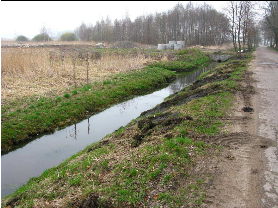
Fot. 2. Istniejący ciek wodny po lewej stronie drogi, widok w kierunku DP 1578N
