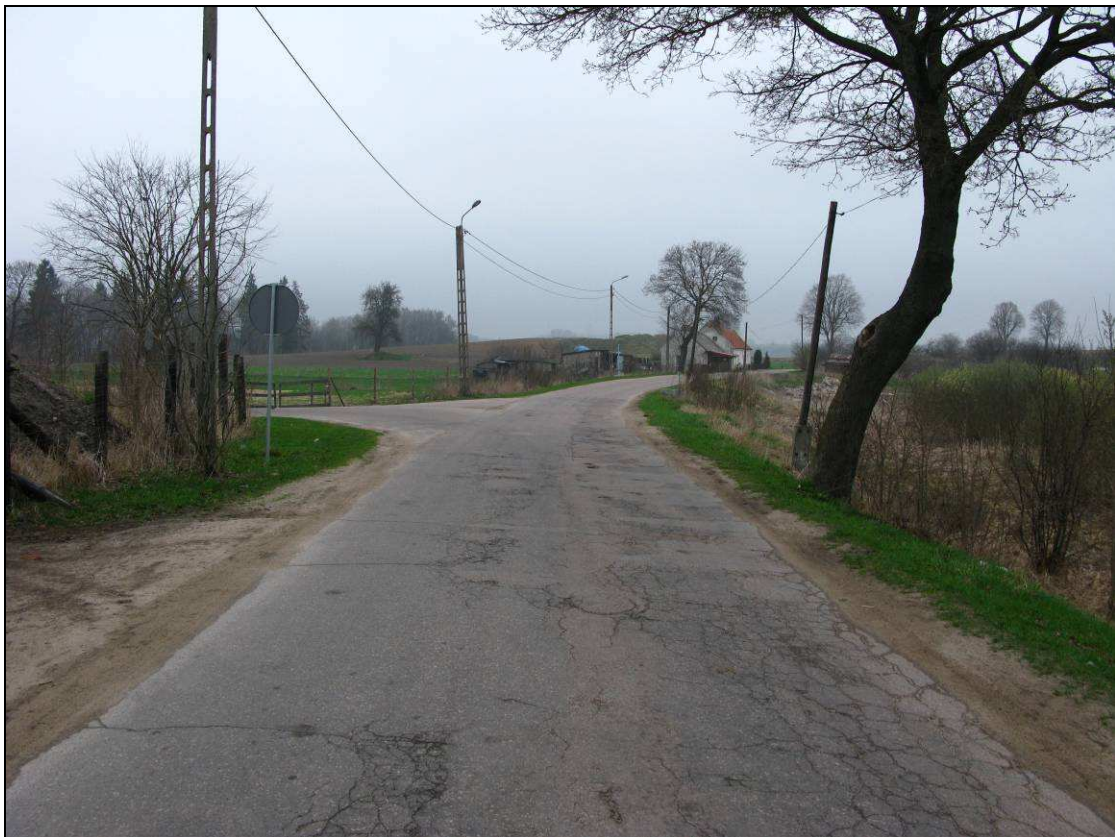
Fot. 5. Skrzyżowanie drogi powiatowej nr 1578N z Al. Wojska Polskiego, koniec opracowania, widok z drogi nr 1578N
