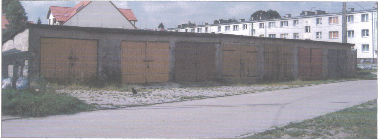
Fot. Nr 2. Widok budynku nr 1 od strony południowej - wschodniej
