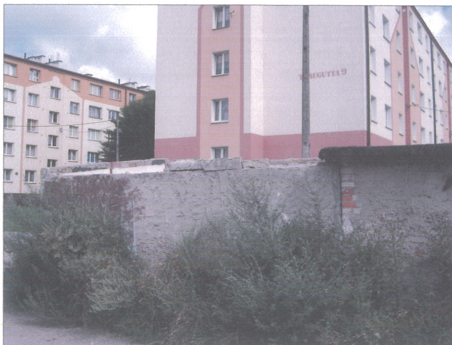
Fot. Nr 4. Widok budynku nr 1 – fragment bez dachu
