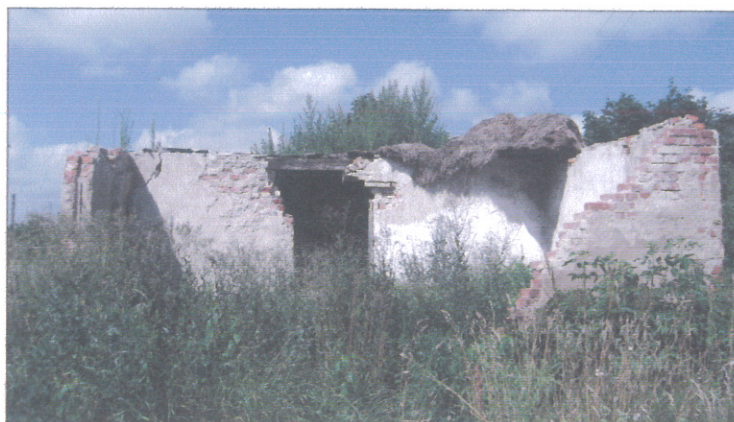
Fot. Nr 5a i 5b Budynek nr 1 – fragmenty ścian
