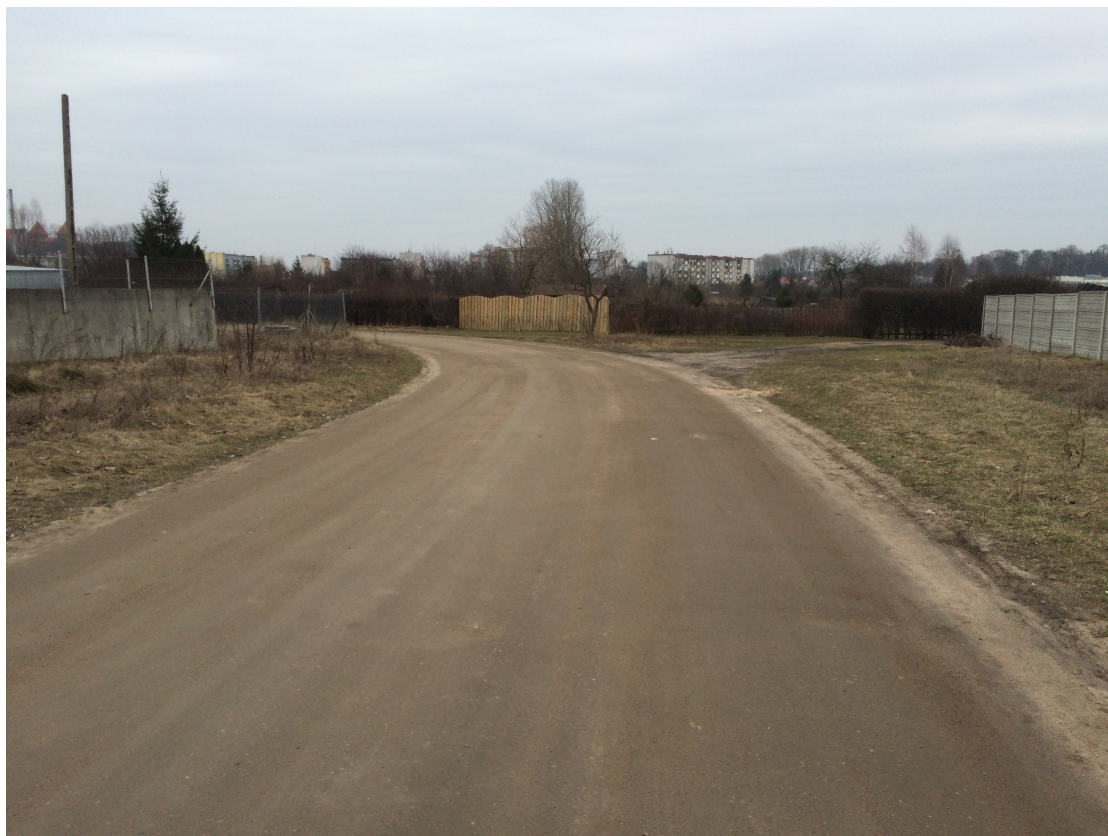
Fot. 4. Występujące łuki poziome o niewielkie wartości promienia.
