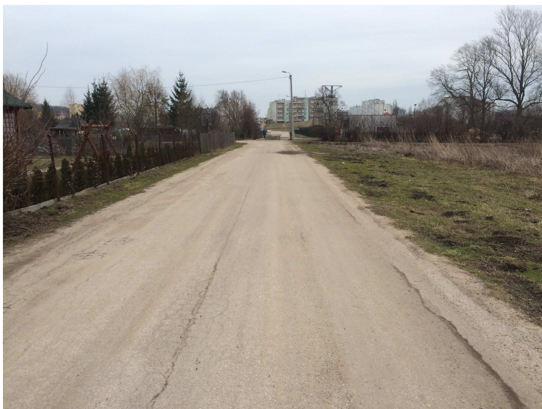
Fot. 5. Końcowy odcinek ul. Kraszewskiego
