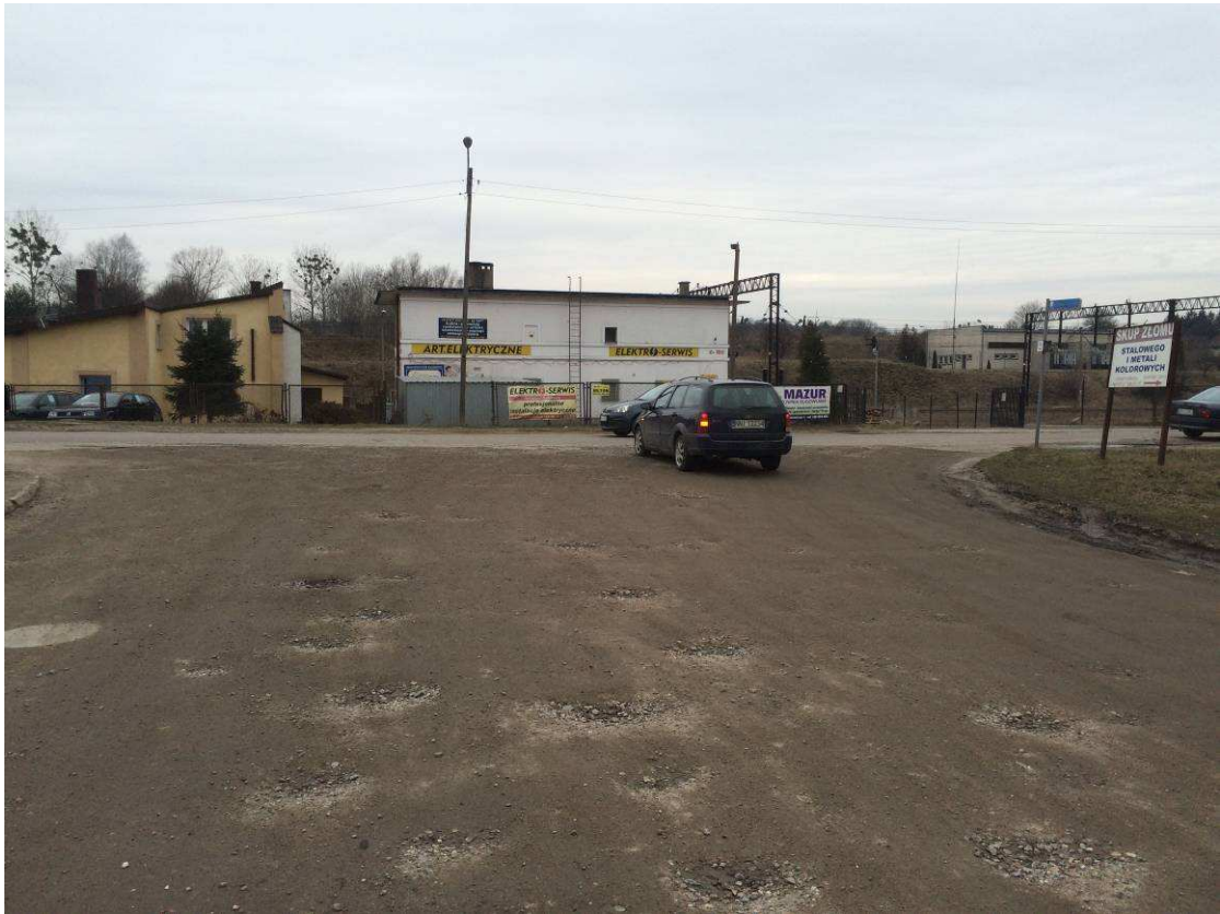
Fot. 1. Początek opracowania – skrzyżowanie ulicy Kraszewskiego z ul. Kolejową.
