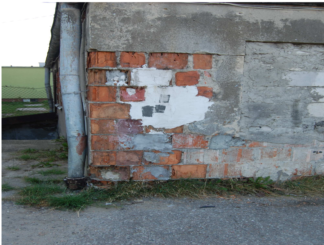
Budynek gospodarczy na działce nr 5-161/21 przy ul. Sienkiewicza w Nidzicy (wg stanu na dzień 30.07.2015 r.)
