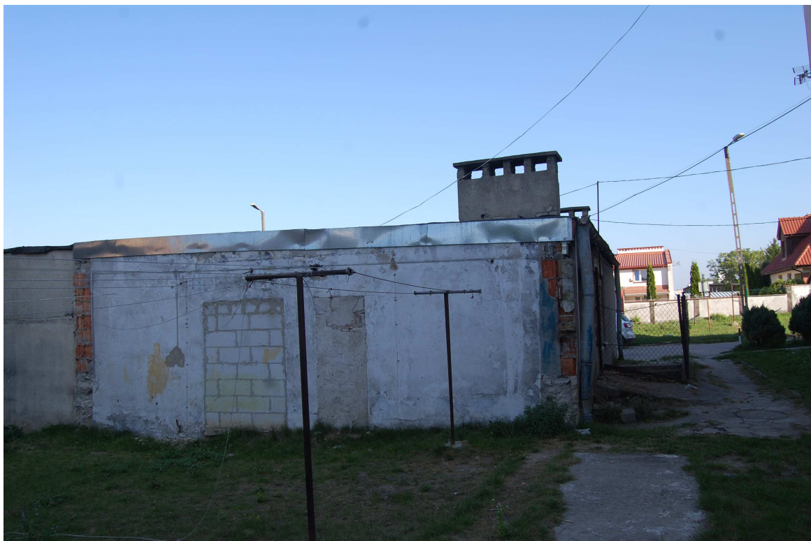
Budynek gospodarczy na działce nr 5-161/21 przy ul. Sienkiewicza w Nidzicy (wg stanu na dzień 30.07.2015 r.)
