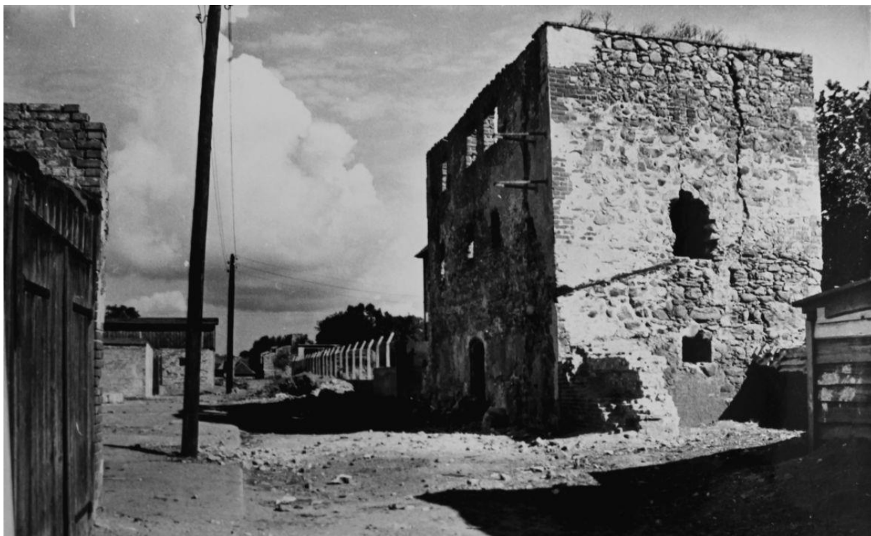
Ilustracja 13. Jedna z trzech zachowanych baszt przy ulicy Murarskiej w roku 1959, ujęcie w kierunku północnym. Zdjęcie z Archiwum PKZ Poznań. Fot. S. Leszczyński
