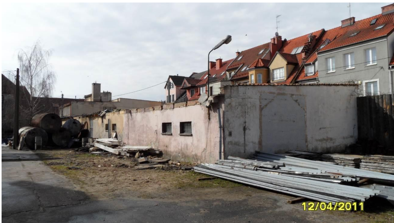
Ilustracja 14. Nidzica. Budynek gospodarczy rozebrany w 2011 roku, w głębi widoczne usunięte z wnętrza budynku zbiorniki. Fot. M. Arcyz, UG Nidzica.
