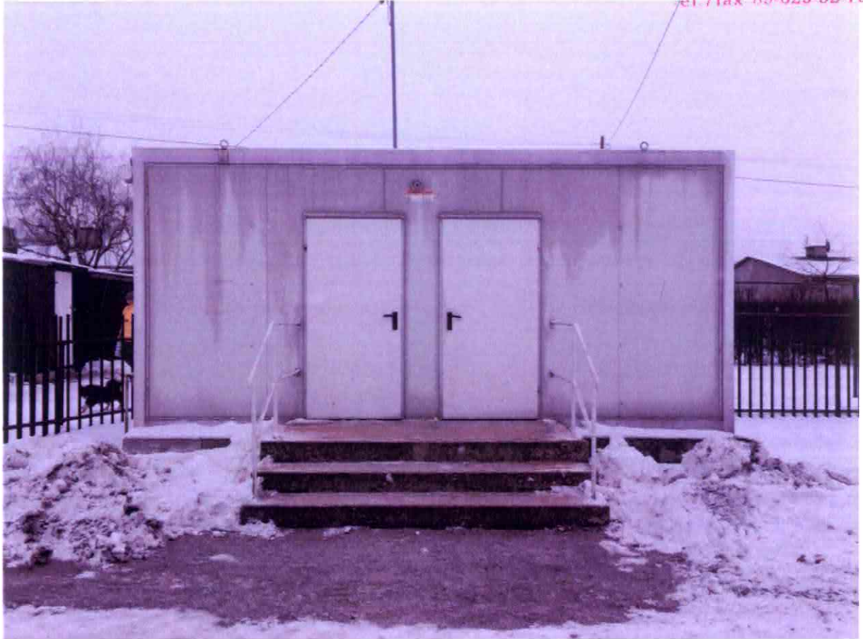
Elewacja frontowa (zachodnia)
