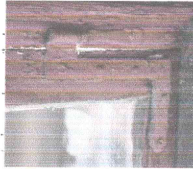
fol. 64 Analogia – zawias kątowy z hakiem i narożnik okienny – okucie łączące i usztywniające konstrukcję ramy okiennej, umieszczone w miejscach złączy (narożach) ramiaków.
