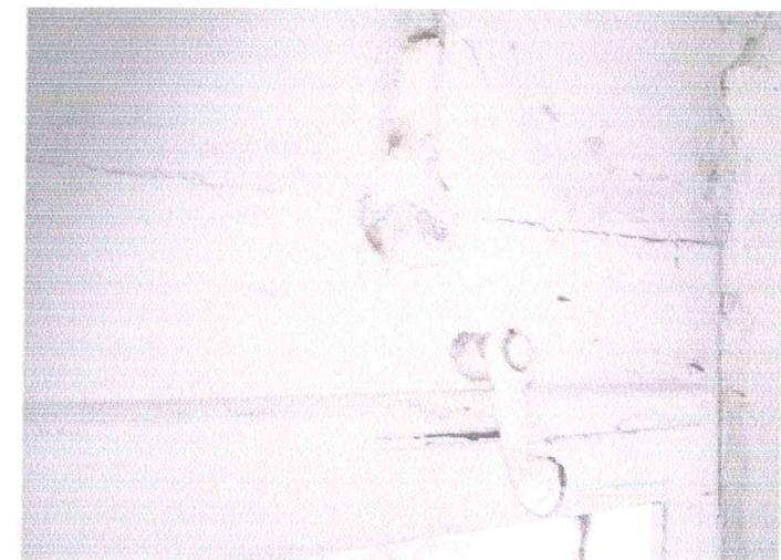
fot. 61 Analogia – okno oszczędniczo-krosnowe z zamku Krzyżackiego w Kwidzynie. Widoczna zakrętka okienna i hak do oszczędnic.
