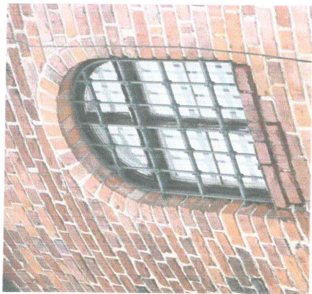
fot. 28 Okno skrzynkowe Baszty w awersie.
