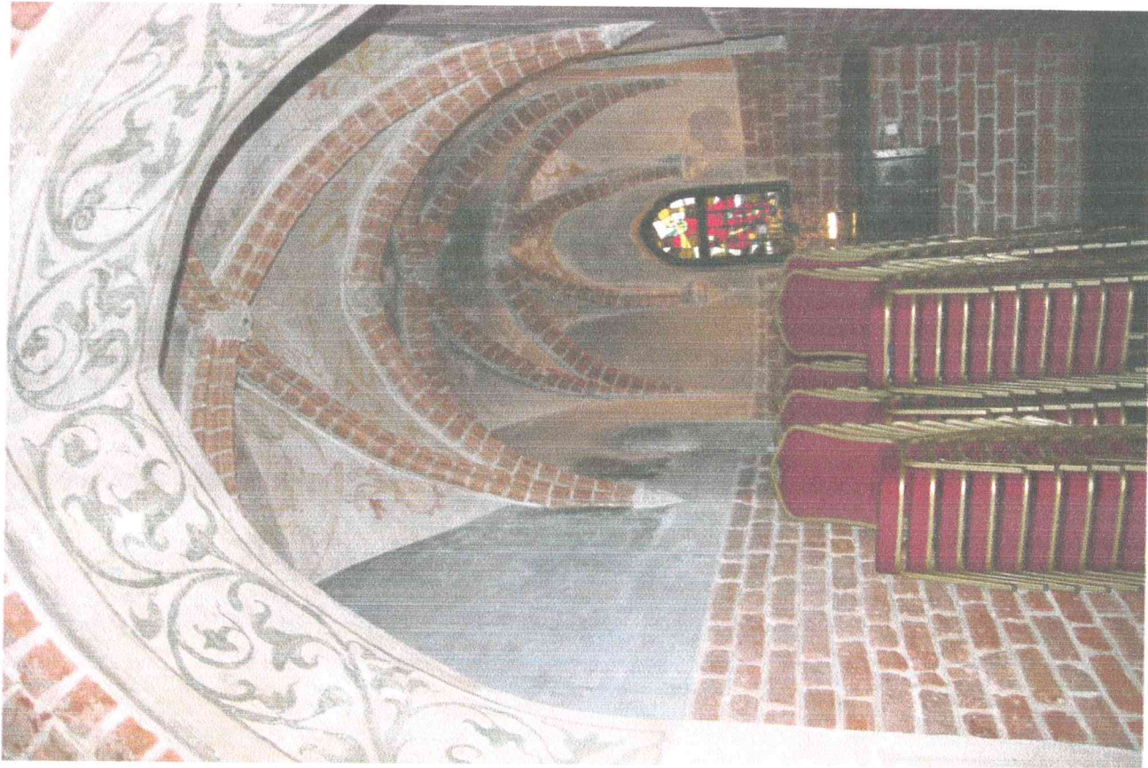
fot. 36 Wnętrze kaplicy w Sali Rycerskiej, stan obecny.
