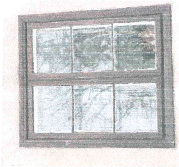
fot. 26 Okno skrzynkowe zabudowań podzamcza w awersie.
