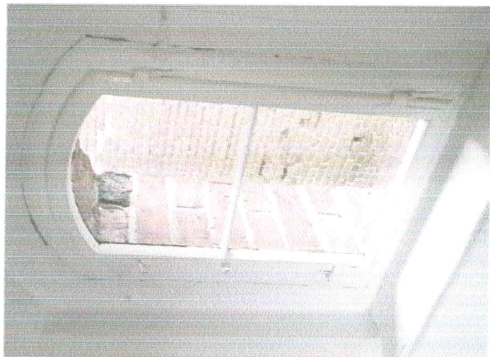
fot. 59 Analogia – okno krosnowe pojedyncze z obokiem umiejscowionym bezpośrednio za węgarkiem z zamku Krzyżackiego w Kwidzynie.
