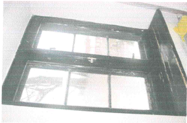
fot. 27 Okno skrzynkowe zabudowań podzamcza w rewersie.
