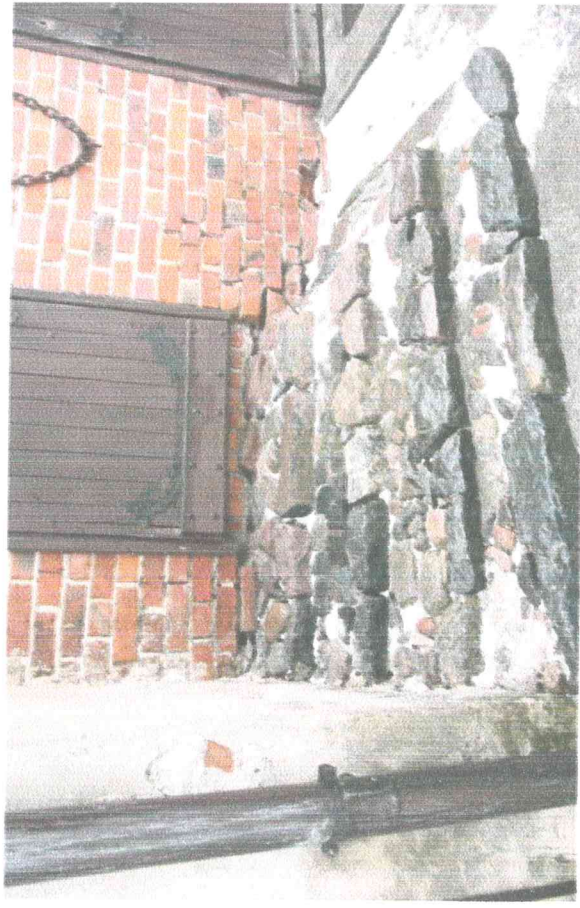
fol. 14 Widoczne schody kamienne z ciosów granitowych, podzamcze, elewacja zachodnia. Stan obecny.
