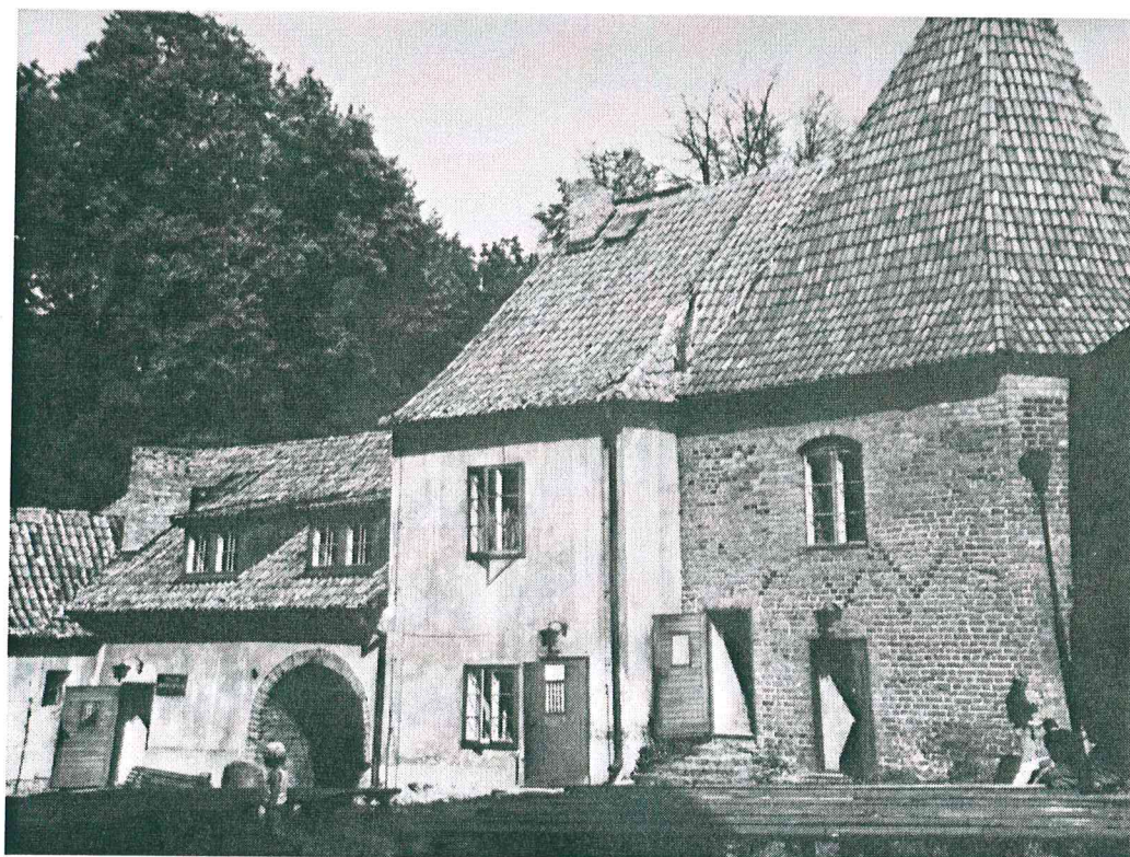
Ryc. 29 Przedzamcze, widok na elewację zachodnią, stan z 1967 r. Źródło fotografii: Dokumentacja P.P. PPKZ Oddział w Gdańsku, Pracownia Dokumentacji Naukowo-Historycznej
