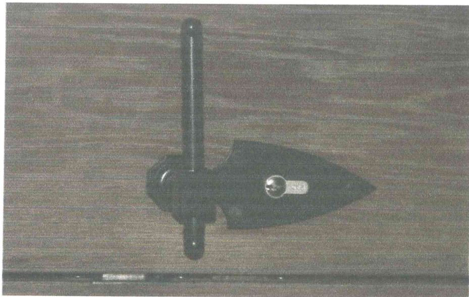
foto. 58 Klamka współczesna spełniająca wymogi konserwatorskie występująca w nowo wykonanej stolarnie drzwiowej występującej w Zamku.
