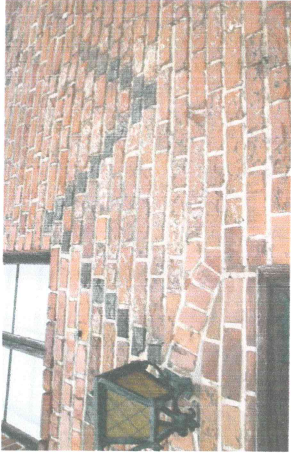
fol. 13 Podzamcze, elewacja zachodnia, fragment muru ceglanoego z odsłoniętym wątkiem ceglanoym. Widoczny wzór utożony ze szklawionych cegiel.
