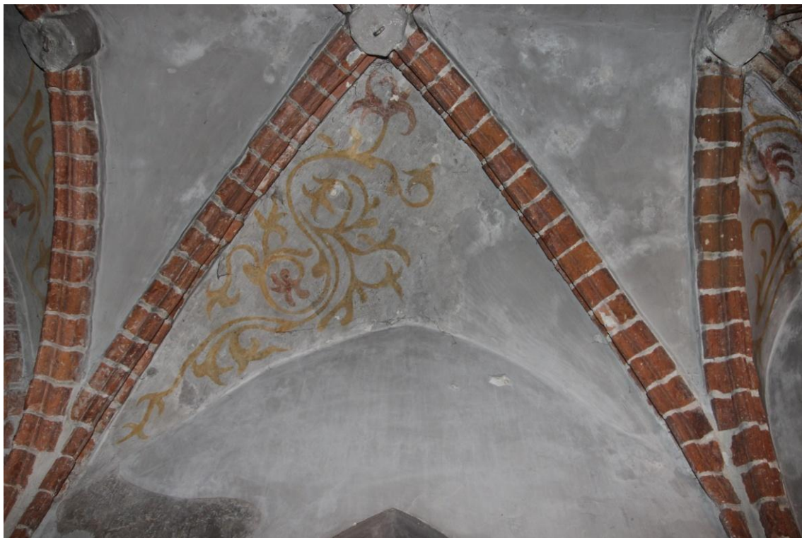
fot. 5 Malowidła w partii środkowego przęsa.
