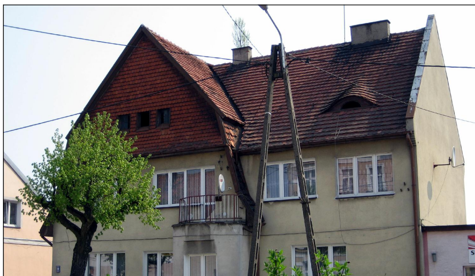
Elewacja od strony ul. 1-go Maja
