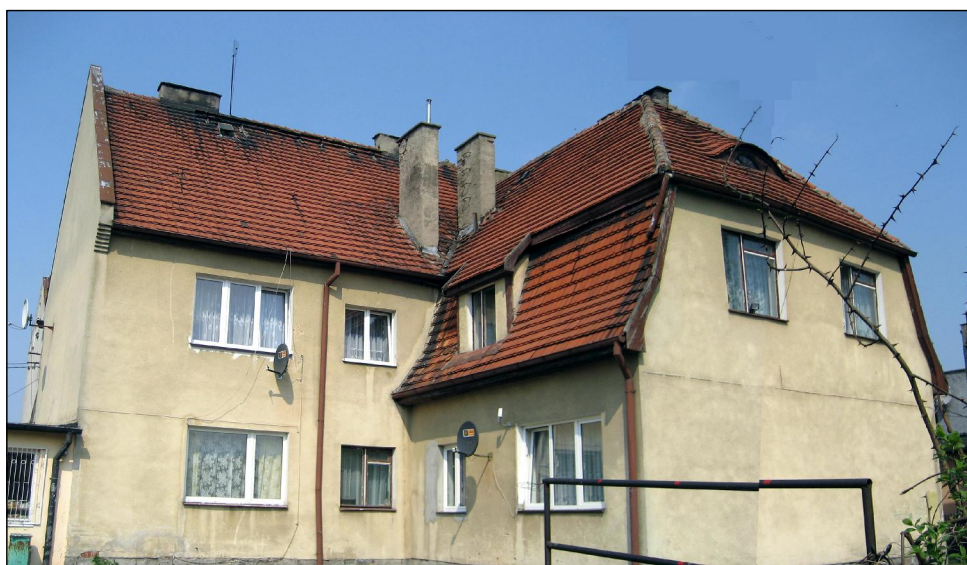
Elewacja od strony podwórza
