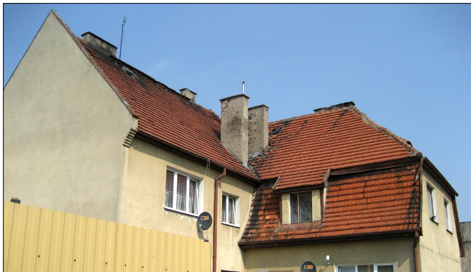
Elewacja od strony podwórza
