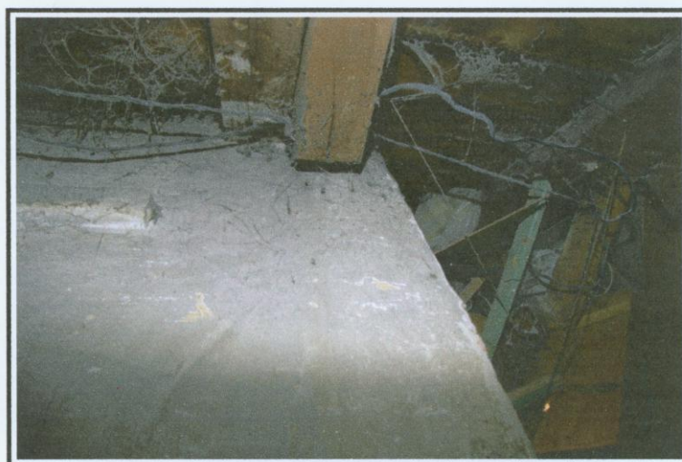
Poddasze w budynku głównym, widoczna instalacja elektryczna.
