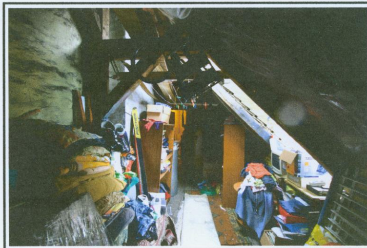
Poddasze w budynku przybudówki, widok w stronę budynku głównego.
