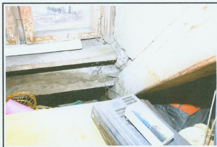
Poddasze w budynku przybudówki, widok na lukarnę.
