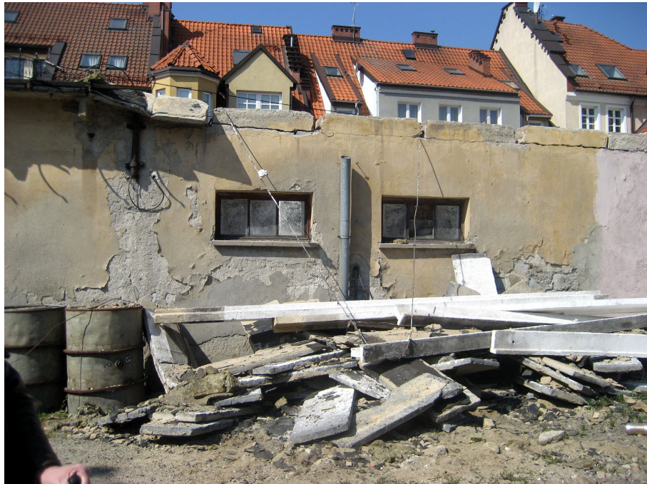
Fot. Nr 6. Wejście do budynku od strony wschodniej
