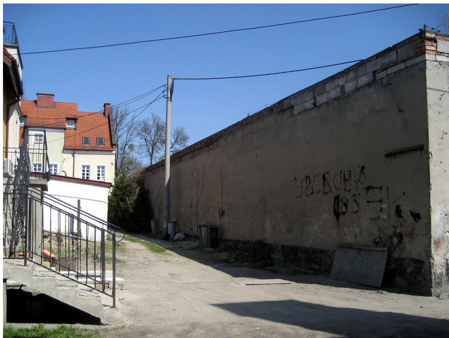
Fot. Nr 7. Widok zachodni
