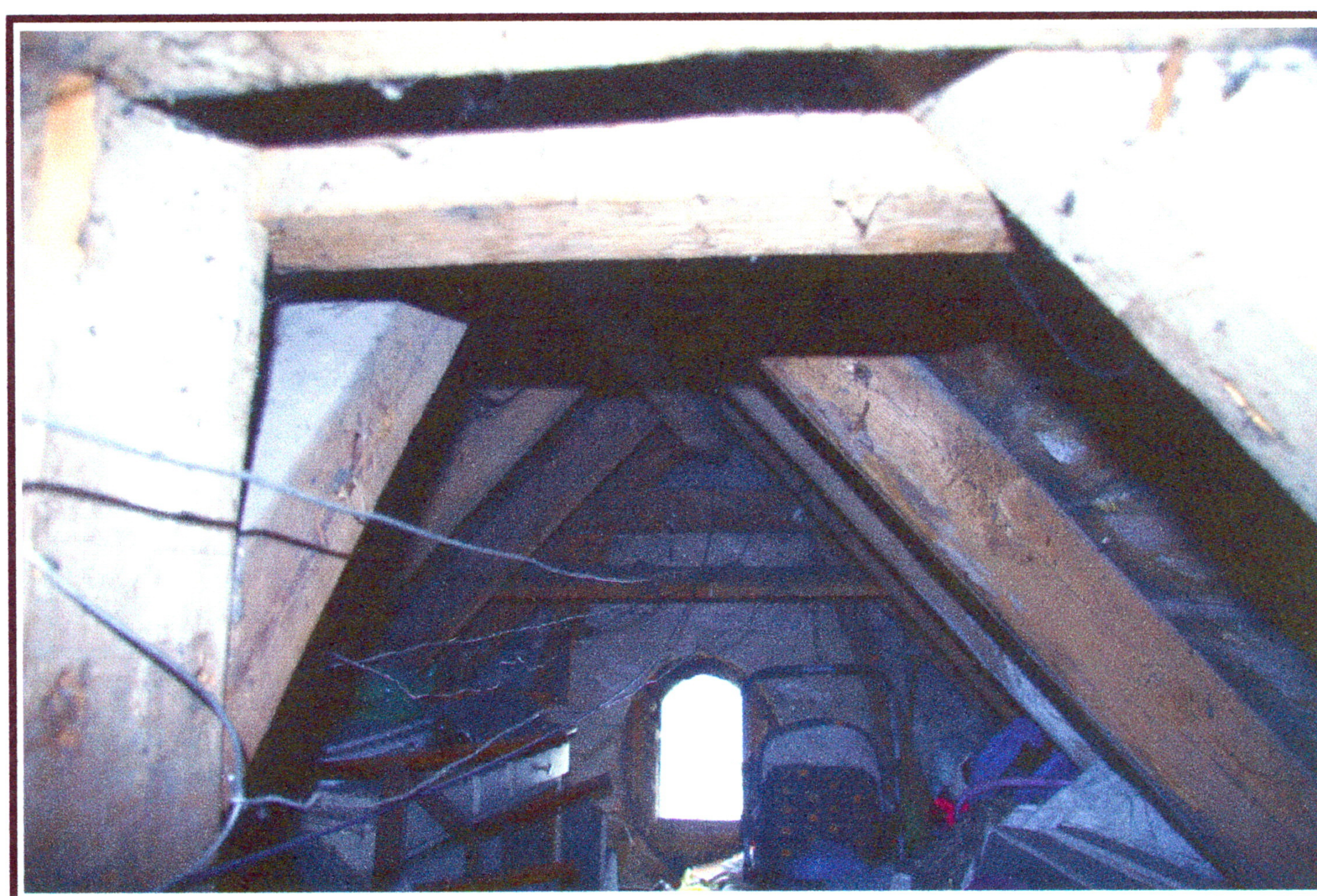
Poddasze - widok w stronę zachodnią.
