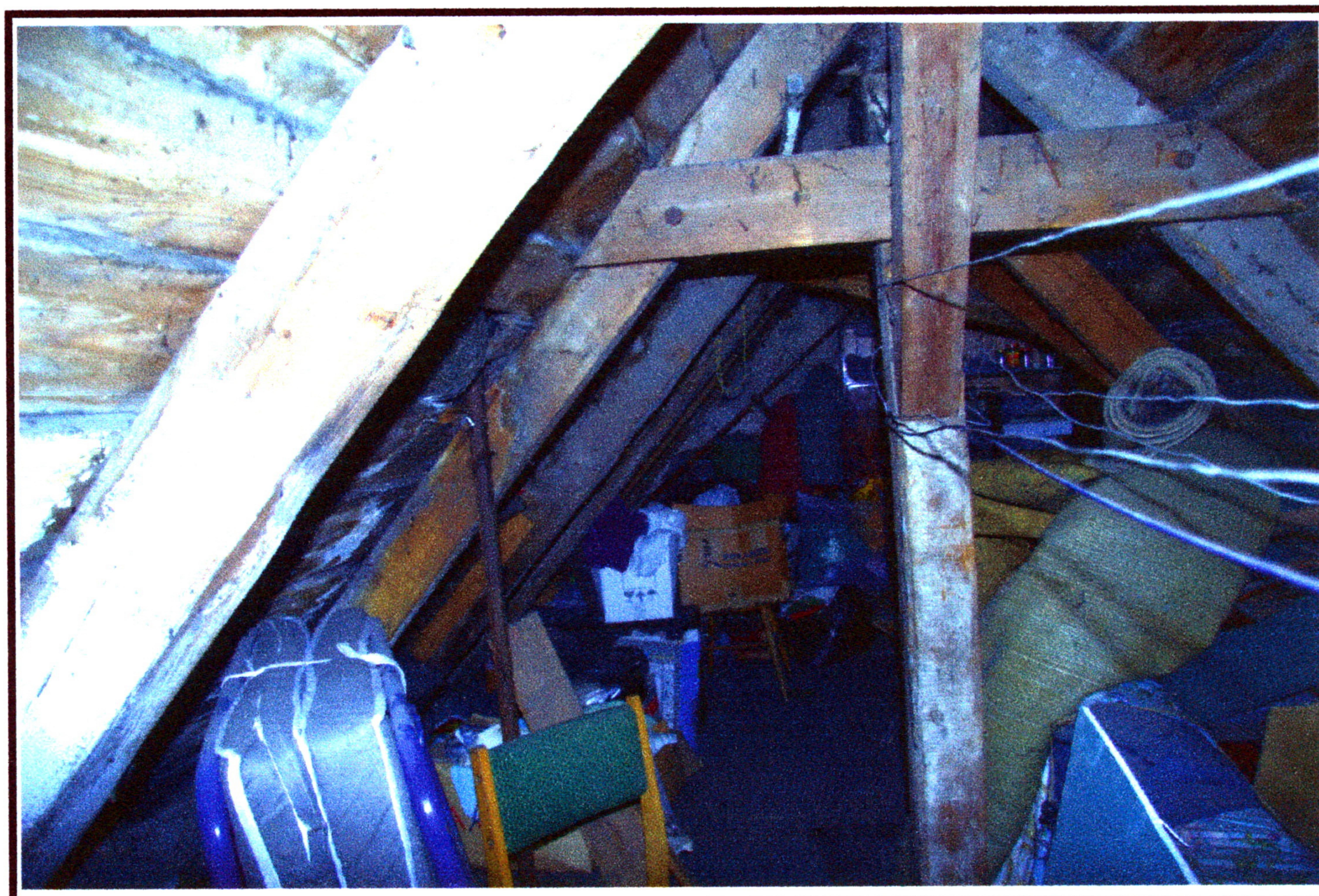
Widok bocznego zadaszania w stronę wschodnią.
