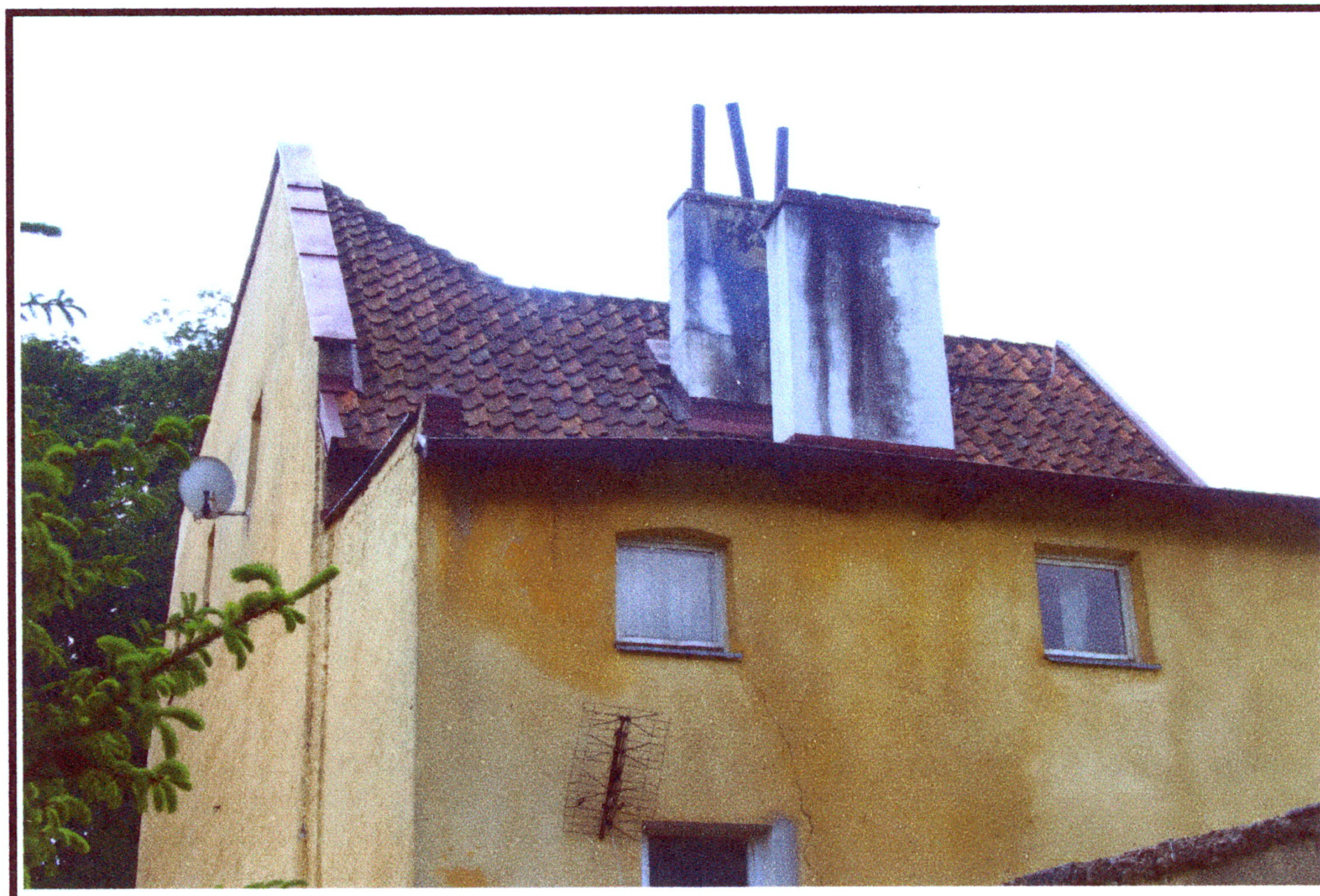
Zdanie elewacji północnej.
