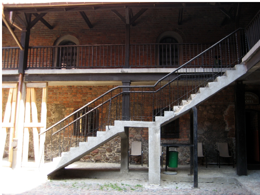
Fot. Nr 7. Schody – strona prawa (południowa) skrzydła wschodniego
