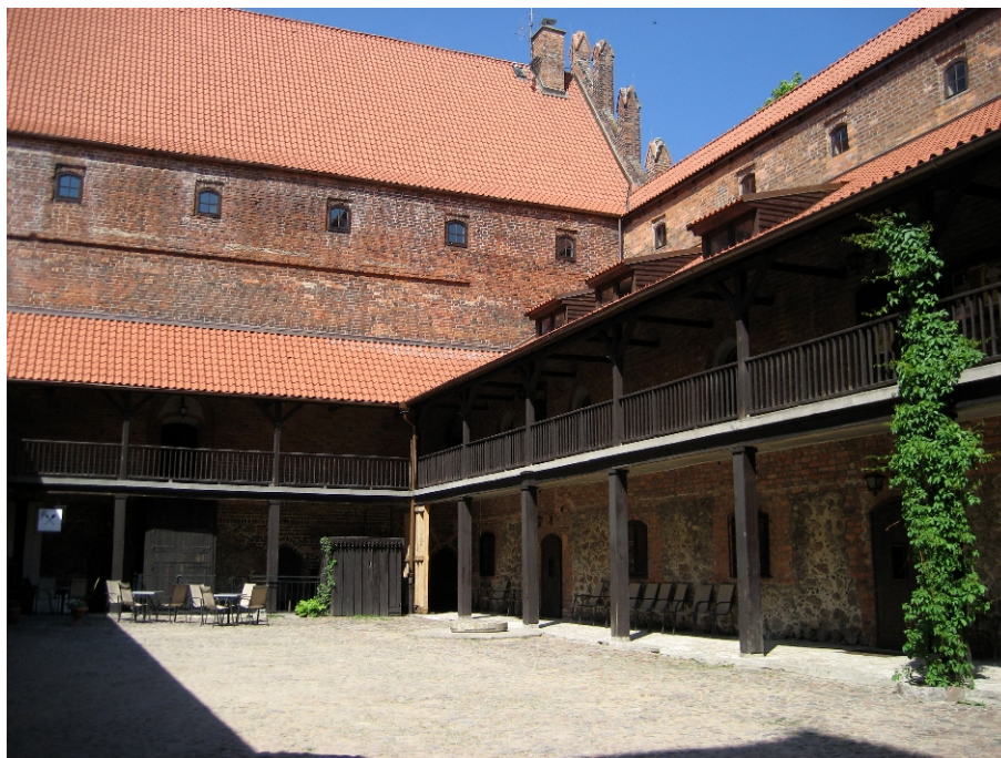
Fot. Nr 3. Widok skrzydła południowego
