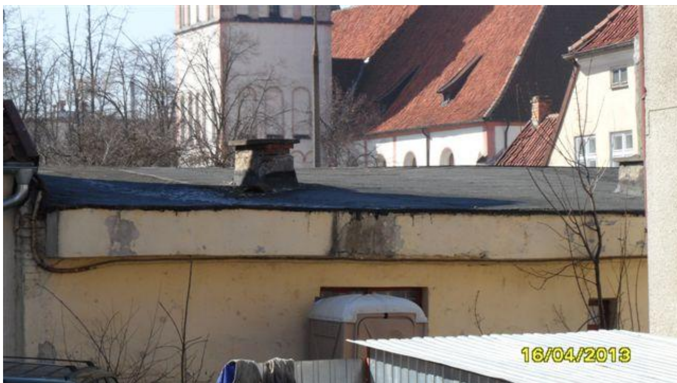
Fot. Nr. 6. Widok budynku – fragment.
