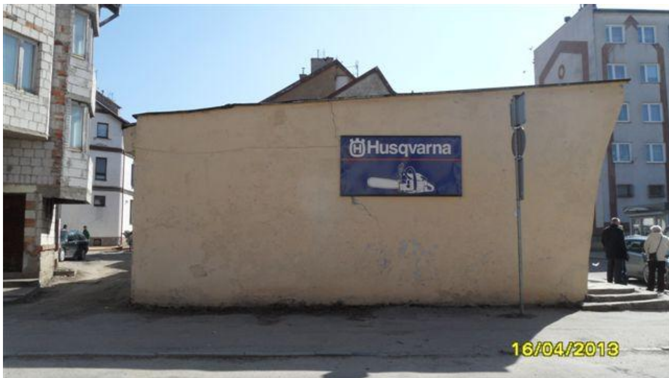
Fot. Nr. 3. Widok budynku od strony zachodniej.
