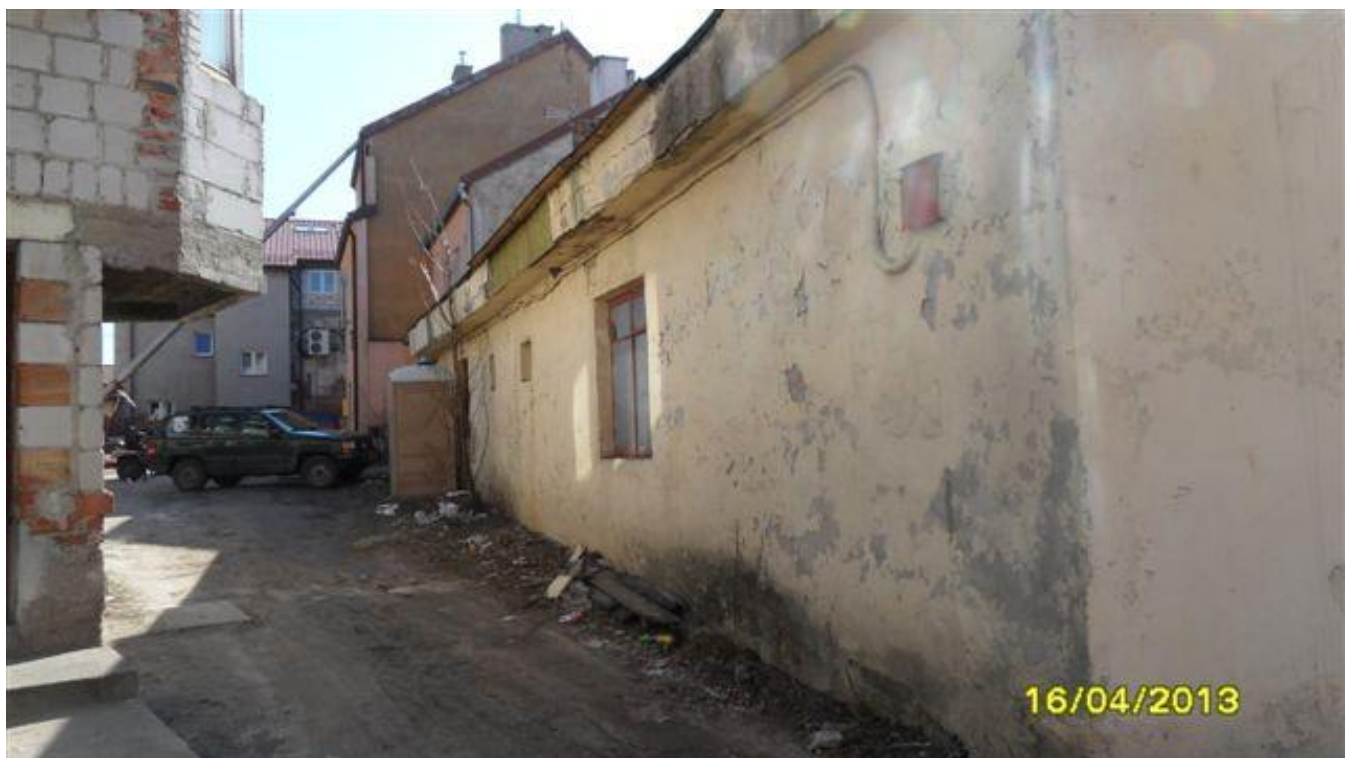
Fot. Nr. 4. Widok budynku od strony północnej.
