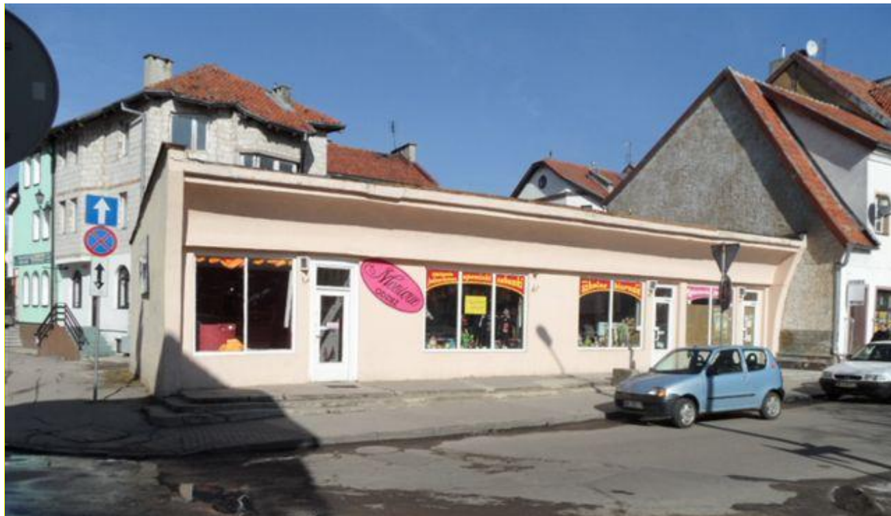
Fot. Nr 1. Widok budynku od strony południowo – zachodniej.
