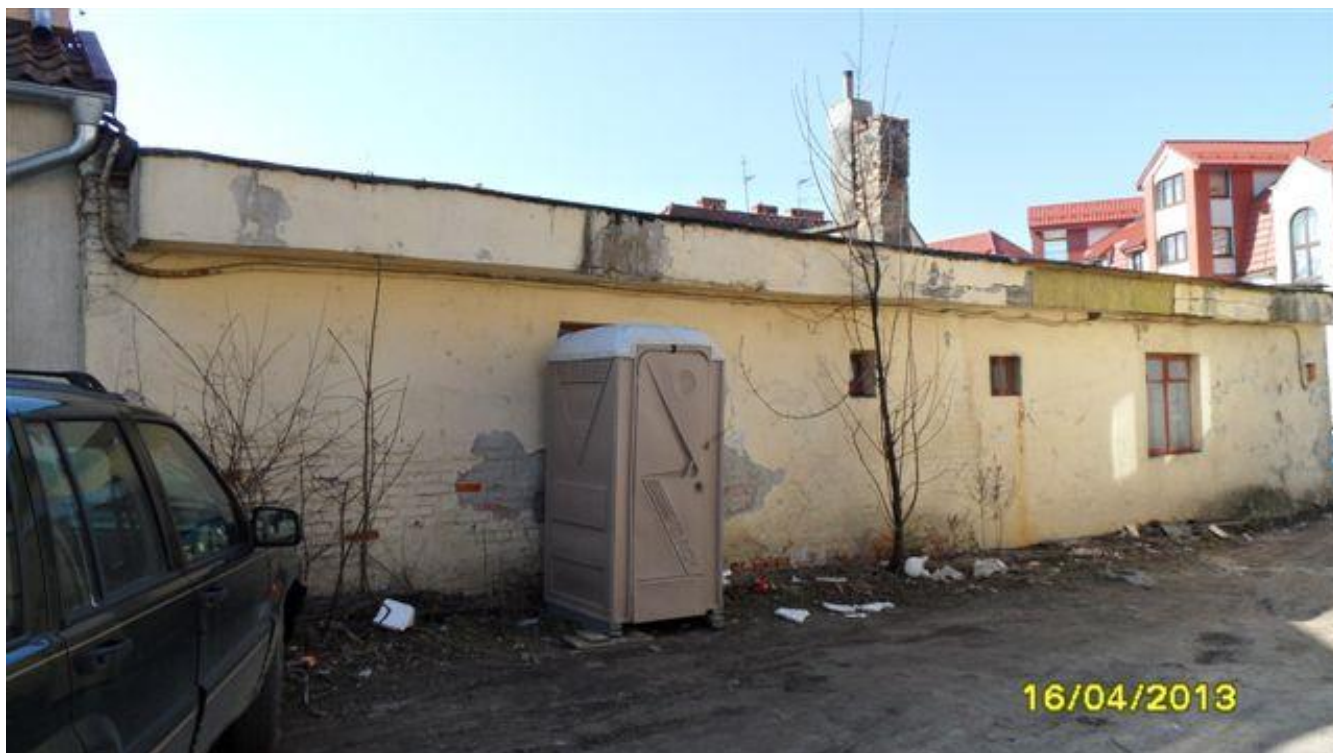
Fot. Nr. 5. Widok budynku od strony północno – wschodniej.
