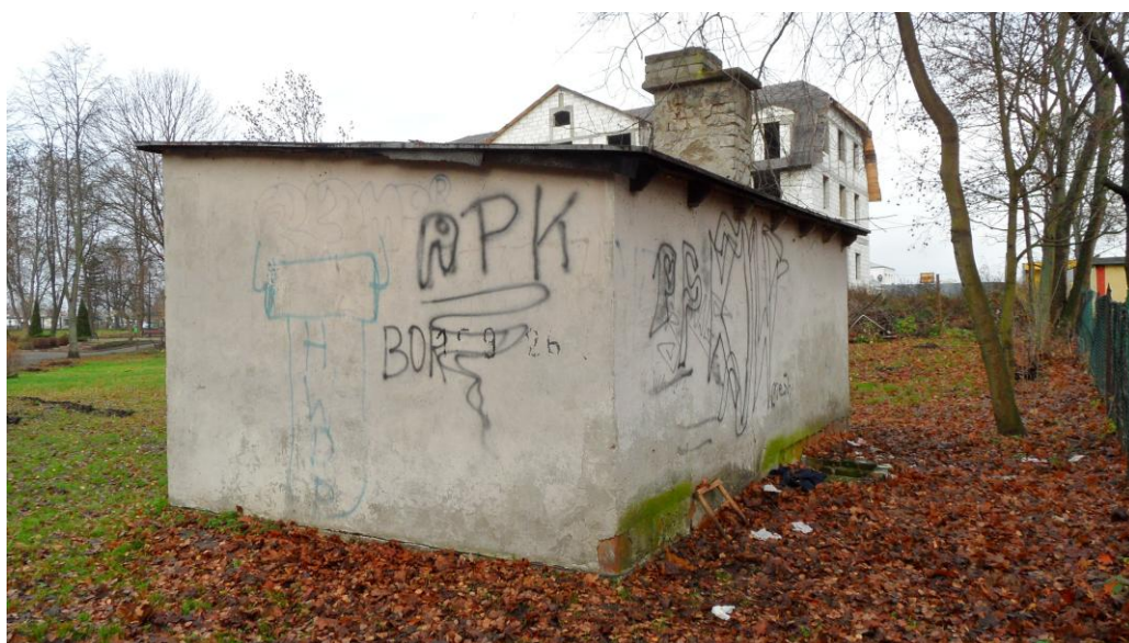
Widok elewacji wschodniej
