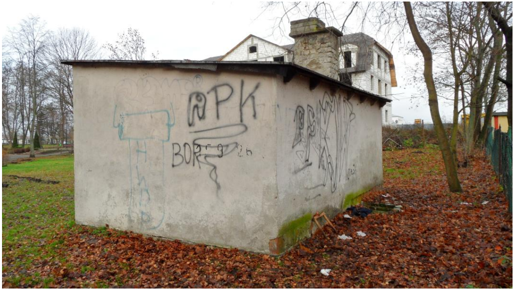
Widok elewacji południowej
