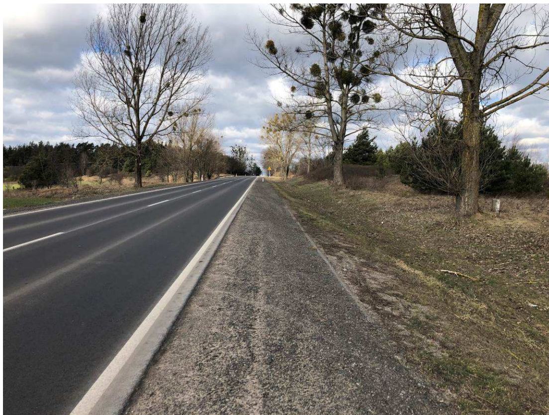
Fot. 3. Odcinek DW 538 – widok w kierunku ronda z DW 545 i 604
