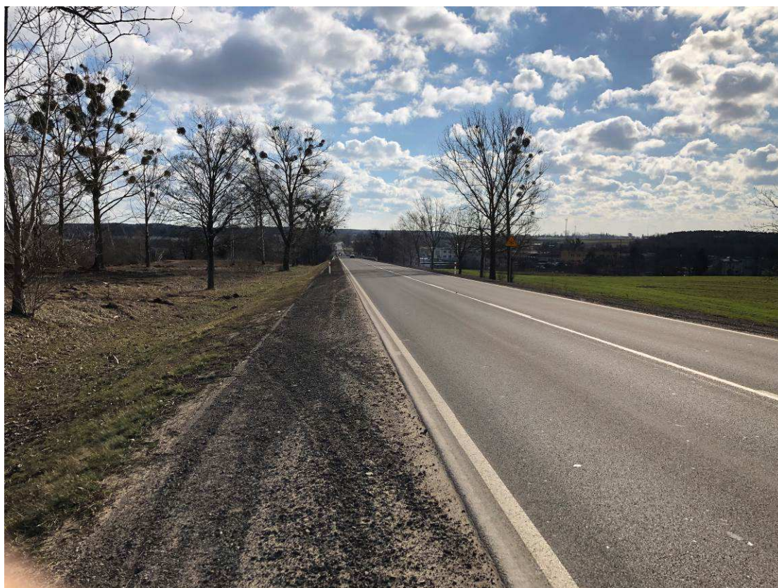
Fot. 2. Odcinek DW 538 – widok w kierunku węzła „Nidzica Południe”
