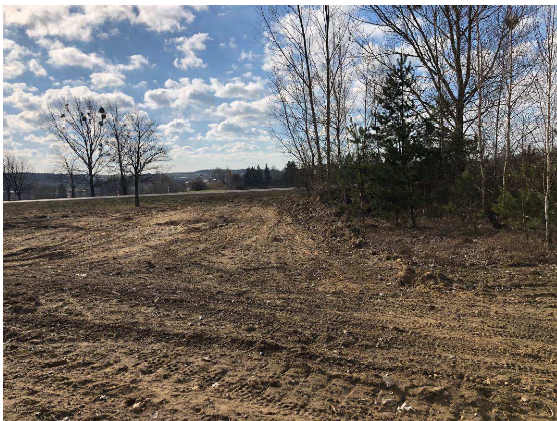
Fot. 8. Miejsce zakończenia budowy 5KDL – widok w kierunku DW 538.
