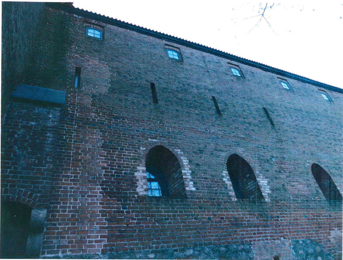
Fotografia 5. Elewacja zewnętrzna północnego skrzydła zamku. Widoczne wąskie otwory strzelnicze – miejsca lęgów ptaków (fot. L. Pietrzak).
