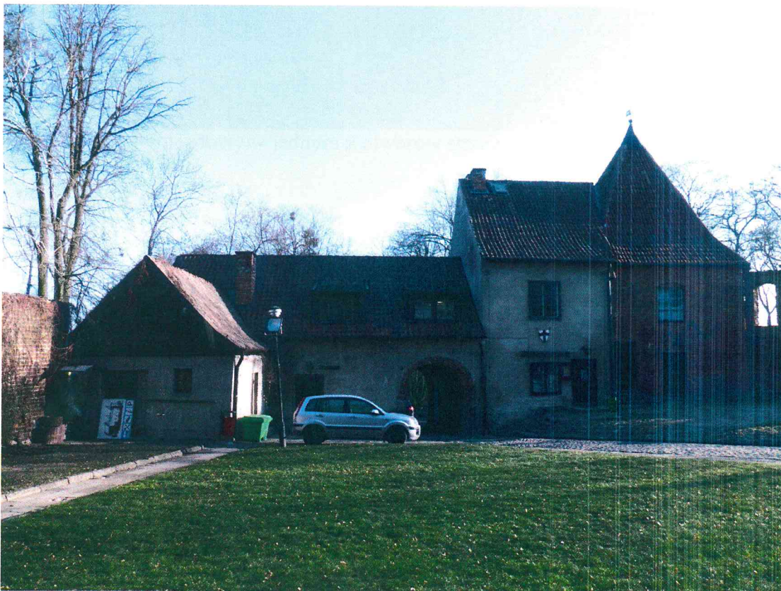
Fotografia 6. Przedzamcze. Strych tego obiektu są intensywnie penetrowane przez kuny (fot. L. Pietrzak).
